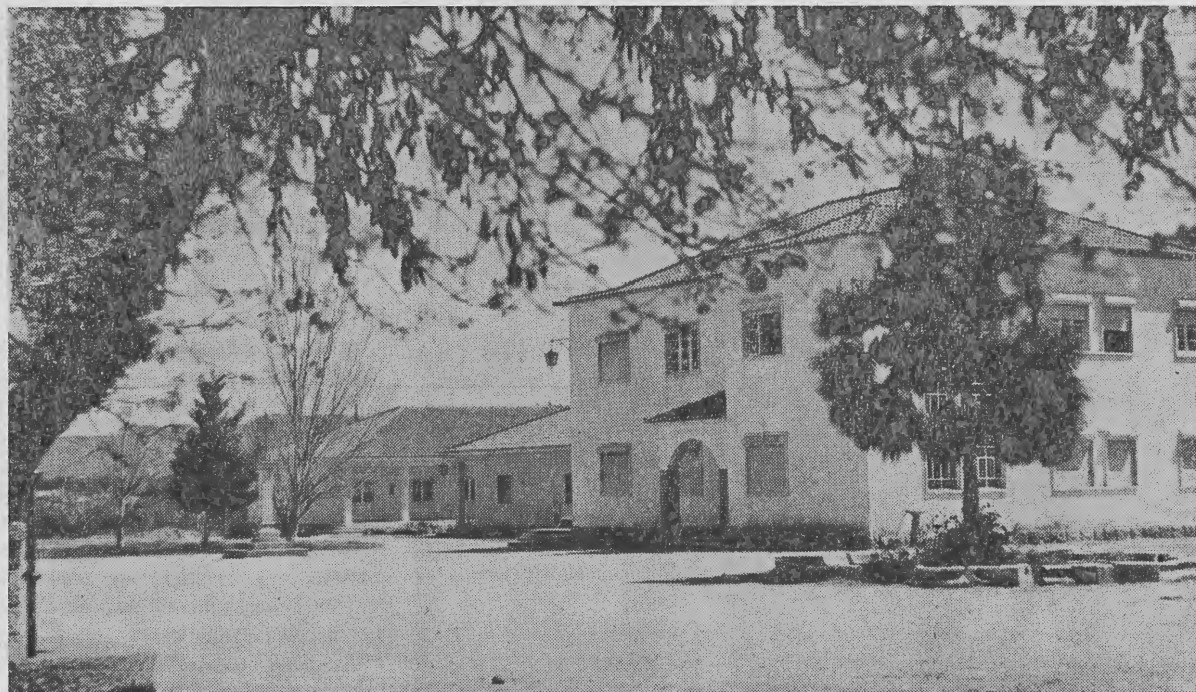
Os escritórios e duas casas de habitação da nossa Aldeia do Tojal
